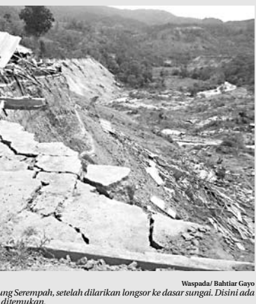
Waspada/Bahitir Gayo INILAH sisa puing Kampung Serempah, setelah dilanda longsor ke dasar sungai. Disini ada 5 korban lagi yang belum ditemukan.
