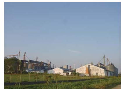
近代的な農業施設
