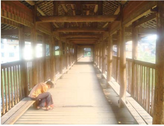
写真7：修理後のA村大橋（内部）。両側の欄干の上部には 光栄榜がはめ込まれている。
