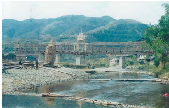
写真4：建設途中の新 A 村大橋
