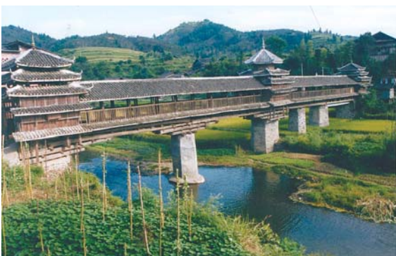
写真5：修理後の A 村大橋
