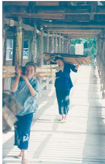
写真2：修理前の A 村大橋（内側）足もとはガタガタの状態
