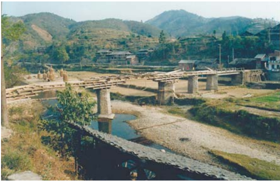
写真3：とり壊された A 村大橋
