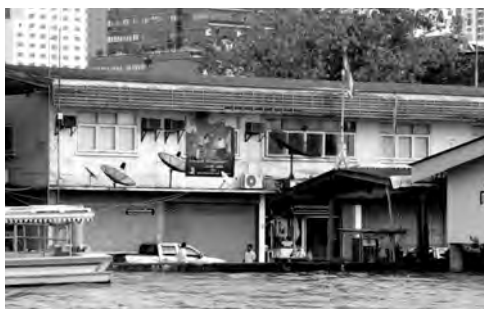
資料1-9 チャオプラヤ川沿いの防水壁
