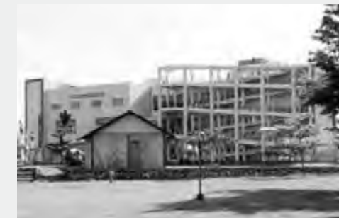
裏手(集団埋葬墓地)側から見たTDMRC。避難階段が見える
