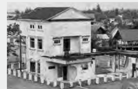
TDMRCの裏手にある病院。3階屋根の上まで水がきた
