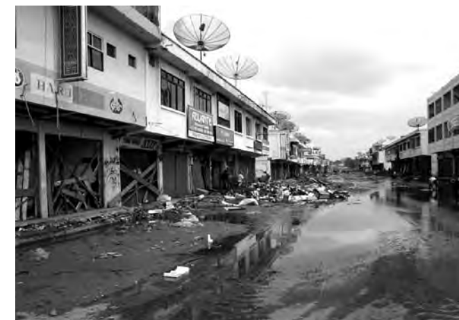
バンドアチェ市の商業中心であるブナヨン地区の被災直後(2005年2月)の写真(上)と復興後(2008年8月)の写真(右)。被災直後は津波によって運ばれた瓦礫で商店の1階部分が壊滅的な被害を受け、道路も冠水した
