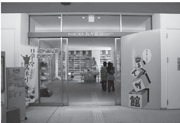
高知県高知市 横山隆一記念まんが館 複合ビルの一部に入っているマンガミュージアムである。
