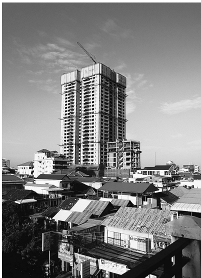
写真2 建築中の高層ビル(2012年8月筆者撮影)
