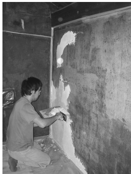
写真2 壁の塗り替え作業
