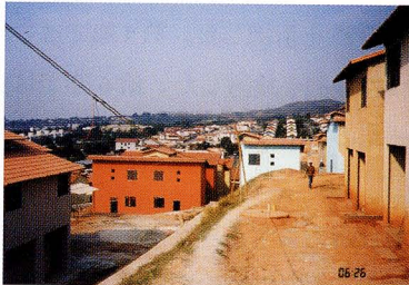
写真3 共同で建設された住宅の例（ブロックを積み上げてつくった外壁にペンキで着色する）
