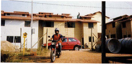
写真1 住宅建設の風景（右側の丸い桶は屋根裏に設置する水槽）
